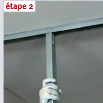
Ossature posée avec montants tous les 600 mm
